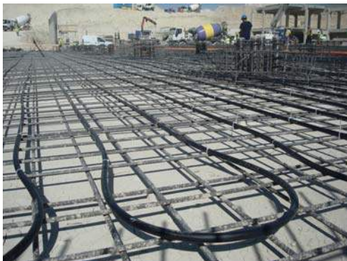
Distribución de sondas geotérmicas en la Losa pilotada de Cimentación Activa
