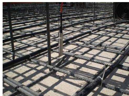
Termocupla embebida en la Losa de Cimentación Activa
