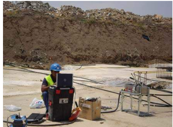
Ejecución de pruebas de carga en las sondas geotérmicas
