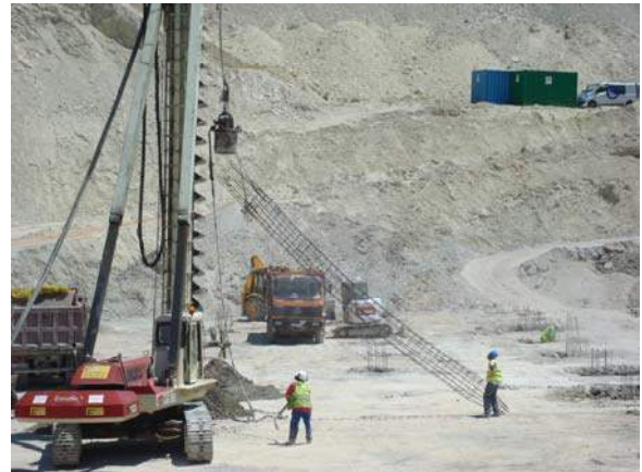
Proceso de instalación de pilotes precavados y hormigonados in situ
